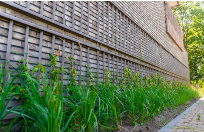
Oude balkonhekken werden ingezet als gevelement.
